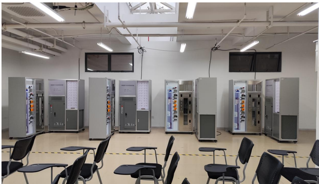
图 1-1-1-2：改扩建的 11#楼一层工程技术学院实训基地实景
